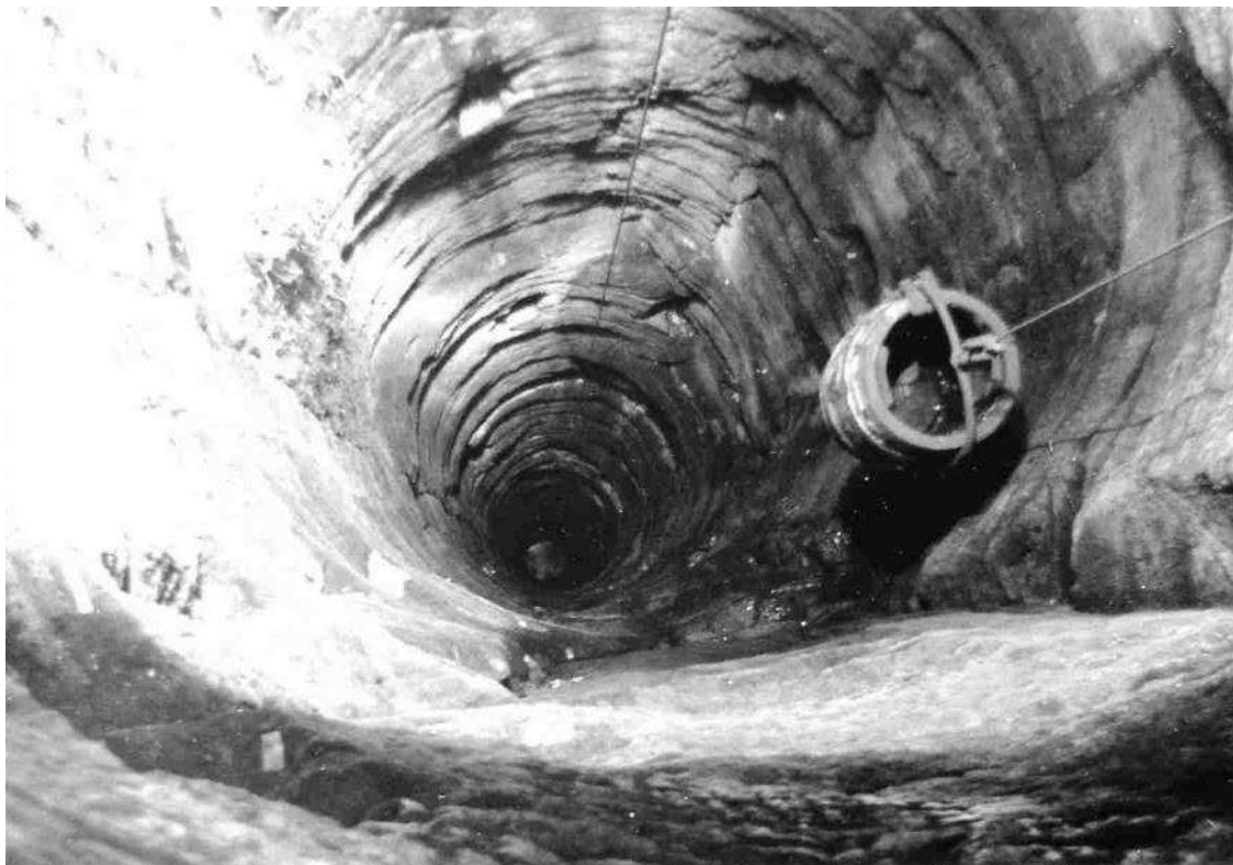
Foto Nr. 2: Blick in den Brunnenschacht
