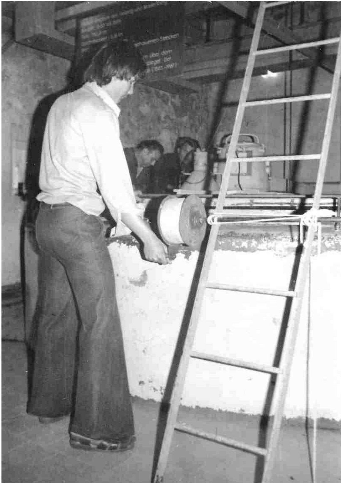
Foto Nr. 3: Bei der Messung der Wassertiefe vom Brunnenrand aus
