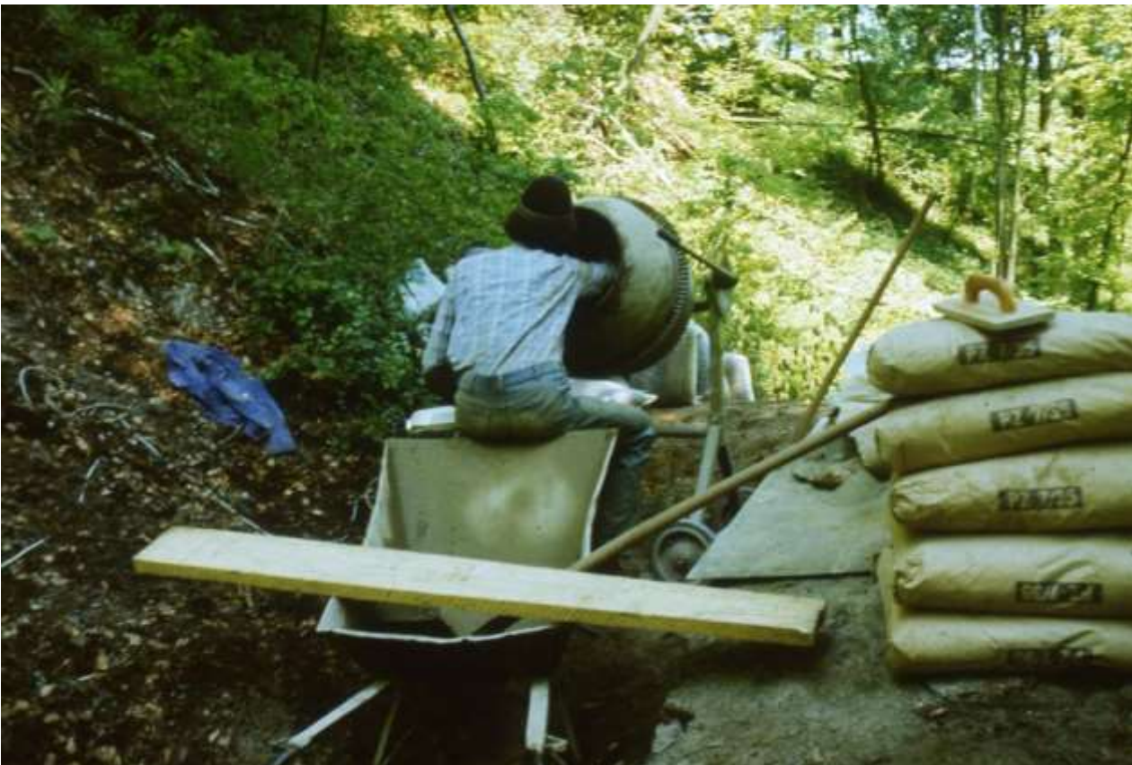
Matthias Winter reinigt den mit Notstrom betriebenen Betonmischer
