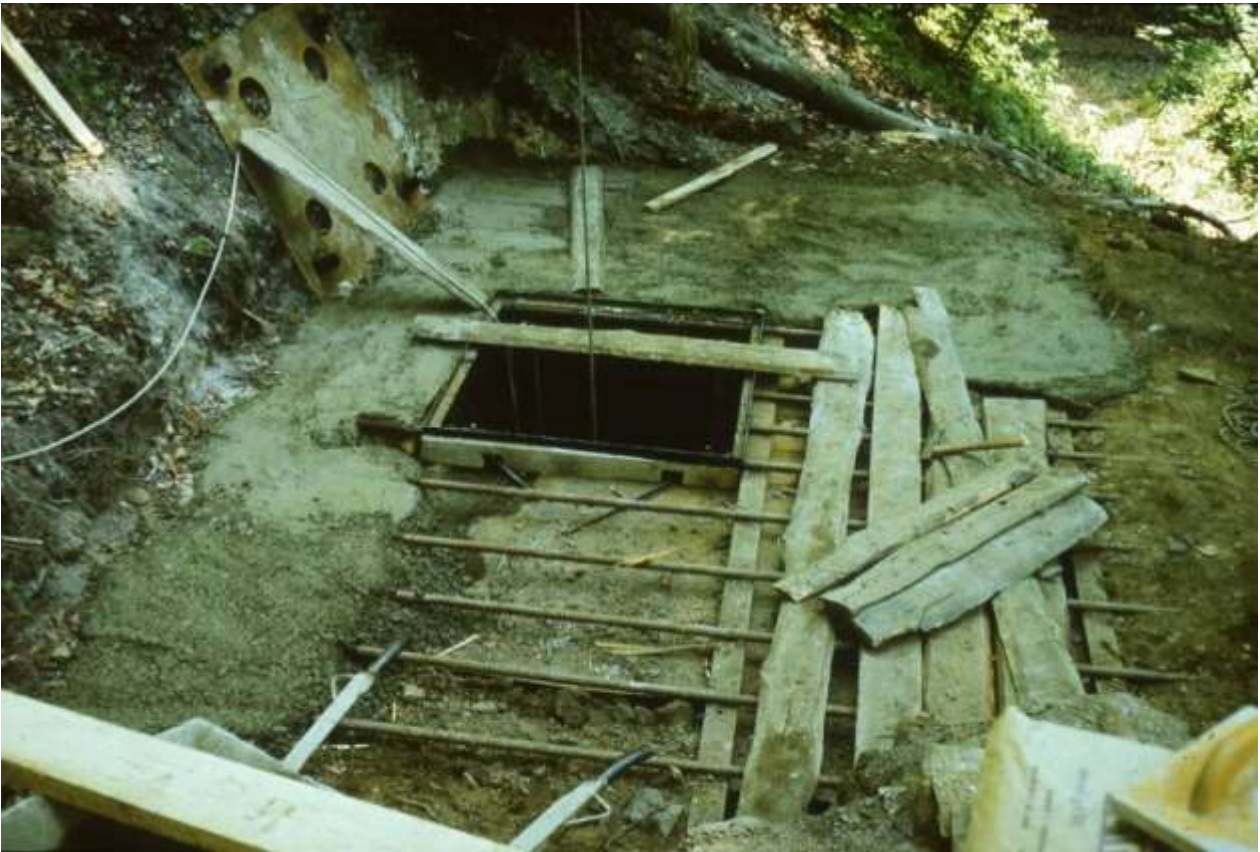
Verwaltungsarbeiten am Reginaschacht (Uftrunger Revier): Karl-Heinz Schmidt („Charlie“) vom Karstmuseum hat zum Deckel auch den passenden Einstiegsrahmen konstruiert, den wir mit in die stahlbewehrte Betonplatte einlassen
