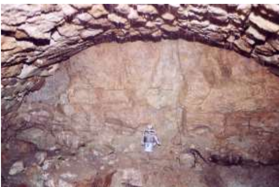
Gewölbe und anstehender Muschelkalk
